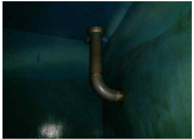
손상내용 1지 배관 유입관부식 상태양호 손상원인 -
