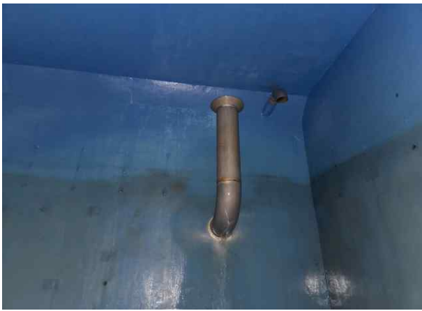
손상내용 2지 배관 유입관부식 상태양호 손상원인 -
