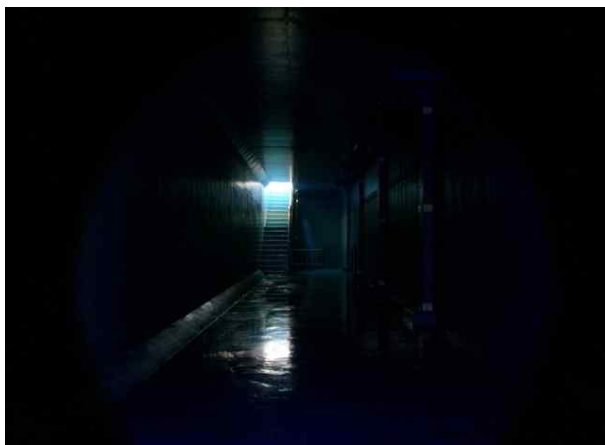
배수지 1지 내부 전경
