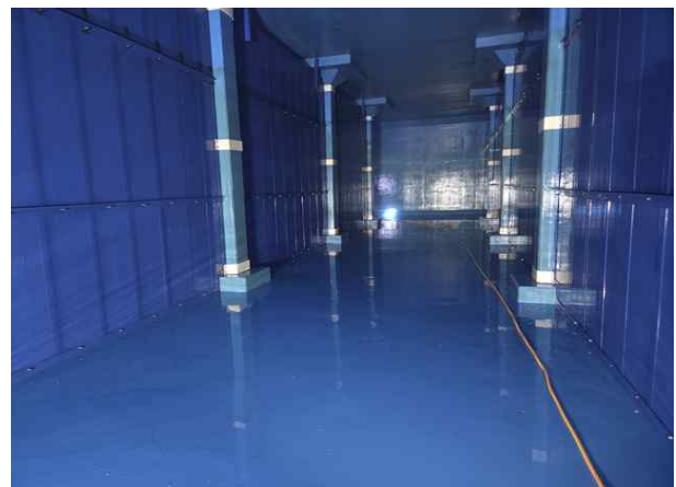
배수지 2지 내부 전경
