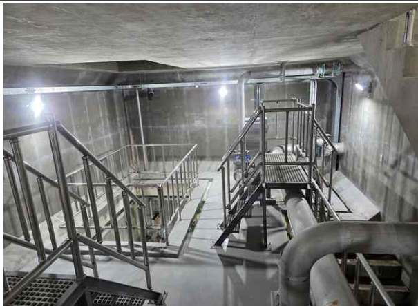
유입밸브실 내부 전경
