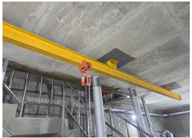
손상내용 레일 및 호이스트 상태양호 손상원인 -
